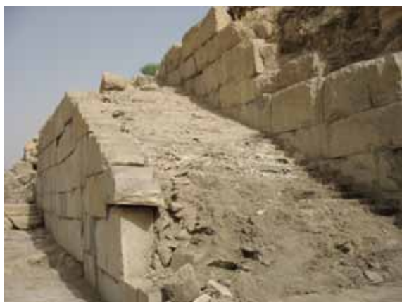
تصویر شماره ۱۶: زیرسازی پله‌های جنوب شرقی معبد که پس از برداشت سنگ کف پله‌ها نمایان شده
