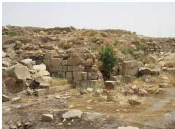
تصویر شماره ۲۲: گوشه جنوب غربی معبد آناهیتا که به دلیل ارتفاع بسیار زیاد و ناپایداری فروریخته است
