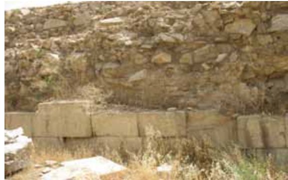
تصویر شماره ۱۷: نمونه‌ای از زیرسازی نمای معبد با استفاده از سنگ‌های لاشه و نخاله به همراه ملات گچ
