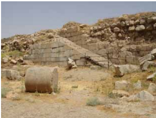
تصویر شماره ۱۴: شسته شدن ملات و نمایان شدن سنگ‌های پشت‌کار در دیوار و پله جنوبی
