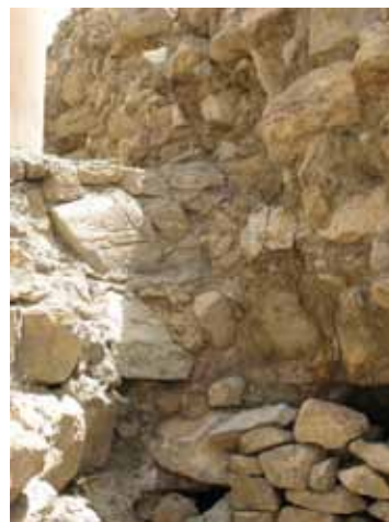
تصویر شماره ۹: نمونه قسمت‌های پر شده از قطعات سنگ و ملات
