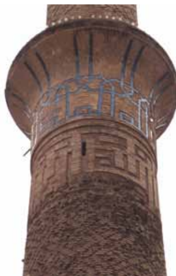
تصویر شماره ۳: جزئیات از خط معقلی شطرنج بندی‌ها و ... ساده آجری «خط معقلی کاشی به عبارت «الملک له» مکرر، توأمأ با نقش گره طبل» در تونگان سازی میل مسجد علی (ع) (دوره سلجوقی، بازسازی معاصر).
