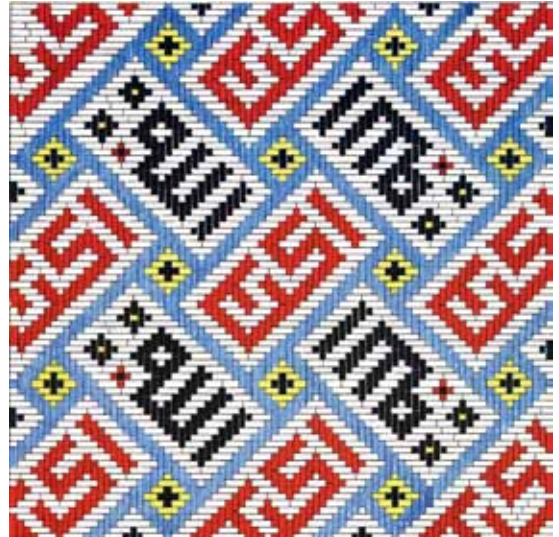
تصویر شماره ۸: نقش از کار اجرا شده در غرفه‌های دو ایوان شرقی و غربی مسجد جامع گوهرشاد به عبارت: ۱- کلافکشی چهارکشیده، چهار؛ ۲- خط خفته و راسته بنایی «الله اکبر» (دوره تیموری).
