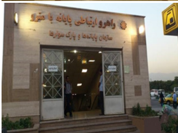
تصویر شماره ۱ و ۲: راهرو ارتباطی پایانه جنوب با مترو
