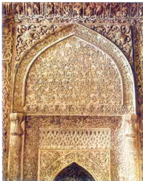
تصویر شماره ۱۰: انواع خط کوفی، ثلث، جلیل و ... + ستون و سرستون‌های مدور برجسته + نقش اسلمی خرطوم فیلی و ... (محراب بی‌همتای مسجد الجایتو) در مسجد جامع اصفهان (دوره ایلخانی)، مأخذ: یساولی، ۱۳۷۵
