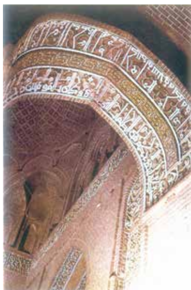
تصویر شماره ۹: گچبری خط کوفی مزهر و ... زیر دور+ کتیبه های افقی و عمودی و نقوش آجرکاری مسجد جامع اردستان (دوره سلجوقی)، مأخذ: یساولی، ۱۳۷۵
