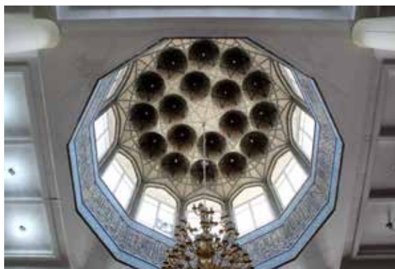
تصویر شماره ۲۴: اجرای شگرف «۱۸ کاسه، رسمی کاربردی دار» منقوش از گلچین‌های آجر و کاشی ... و کتیبه خط ثلث شبستان مسجد امام حسین، میدان امام حسین تهران (دوره پهلوی دوم)
