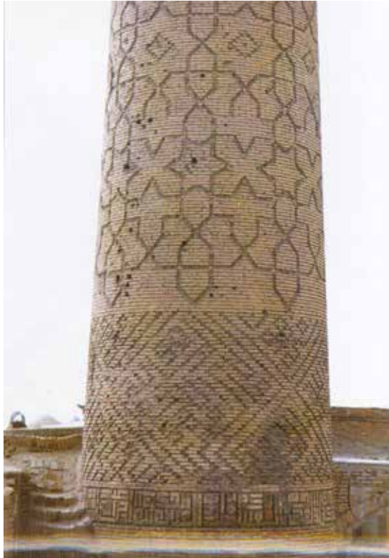
تصویر شماره ۷: خط شطرنجی هزار بافت آجری و نقوش گره آجر (طبل سه گرون شش)، شروع ساقه منار گلدسته مسجدعلی، اصفهان (دوره سلجوقی)
