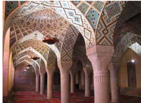
تصویر شماره ۲۱: ستون‌های پیچ تراش سنگ «بوتنه جقه‌ای» تاق‌پوش‌های «پاتوپا» «رسمی» و نقوش شگرف معقلی از «گره طبل و ... و خورشیدی منقوش معقلی و ...» شبستان مسجد بی‌نظیر حاج حسین نصیرالملک، شیراز (دوره قاجاریه)
