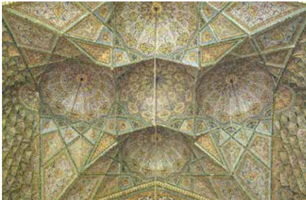
تصویر شماره ۲۲: «پنج نیم کاسه گونه سازی»، قطعات کاشی هفت رنگی و از نقوش، رواق بی‌همتای مسجد حاج حسین نصیرالملک شیراز (دوره قاجاریه)
