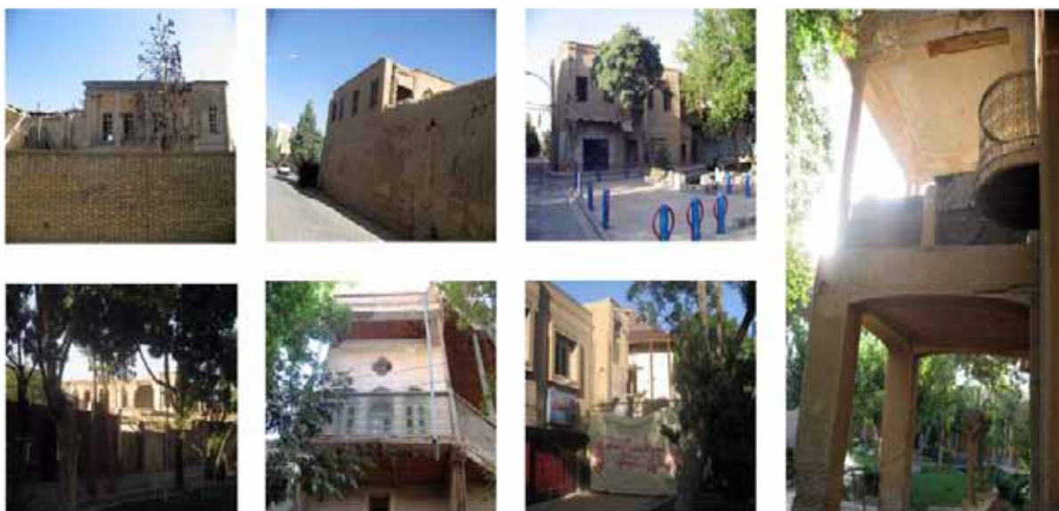
شکل شماره ۹: نمونه‌هایی از ساختمان‌های رها شده و ویرانه در محله جلفا
