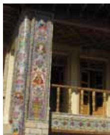
تصویر شماره ۳۲: تزئینات خانه ضیائیپان
